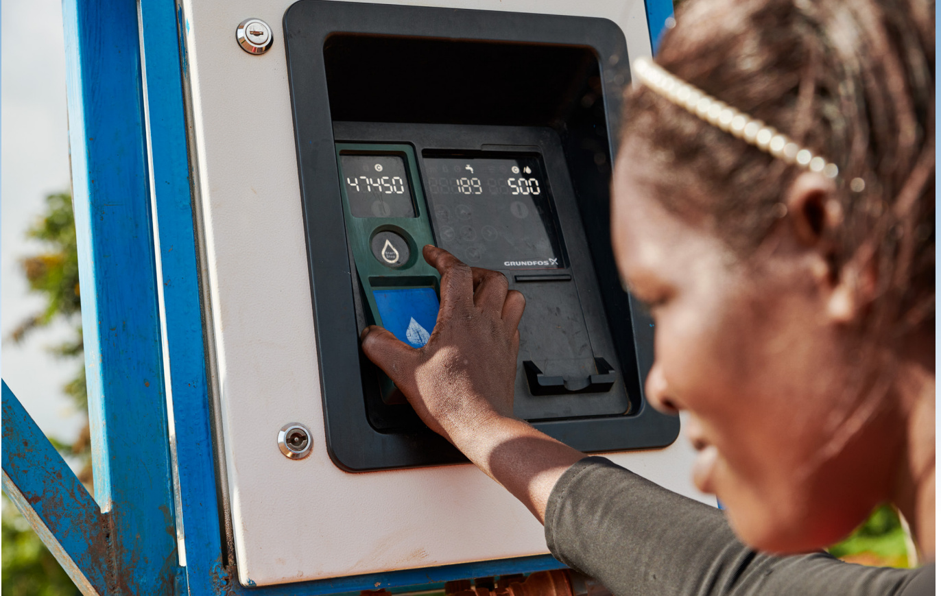
布戈巴村民Annet Kasukya用她的水卡(充值了水费)在格兰富的AQtap自来水ATM上买了20升水。
