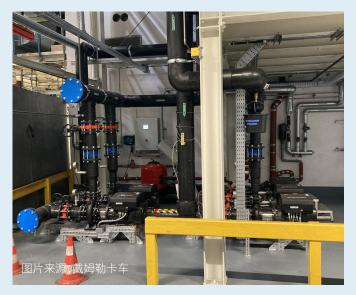
戴姆勒卡车卡塞尔工厂55号车间的三台系统泵和两台冷却 塔泵都进行了升级,并直接在泵上安装了变频器。
